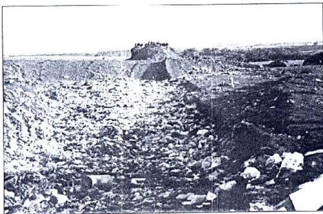
Foto 3 – Vala rasa, aberta para disposição do lixo, que permanece próximo à superfície.
